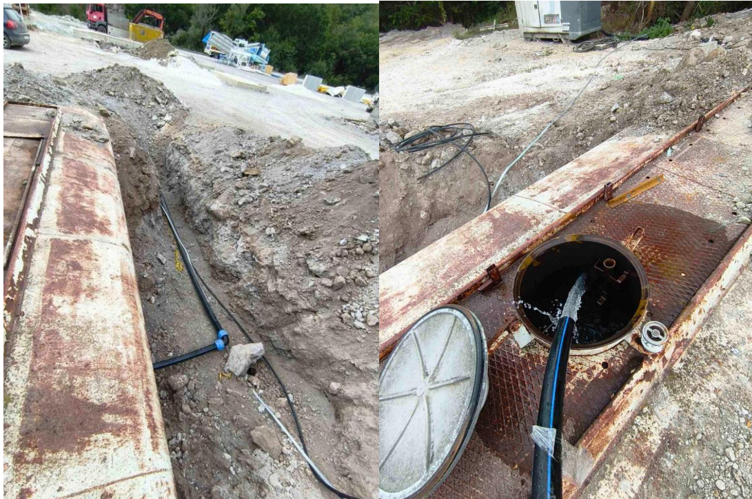
Слика – изглед на дел од системот за снабдување со вода: вкопана цистерна за вода
